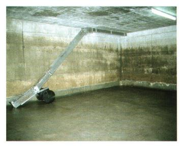
Abb. 13: Ausstiegshilfe für Amphibien in einem unterirdischen Regenbecken.
