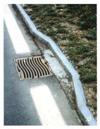
Abb. 14: Amphibien-gerecht gebauter Einlaufschacht.
