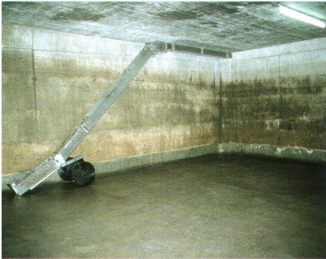
Abb. 13: Ausstiegshilfe für Amphibien in einem unterirdischen Regenbecken.
