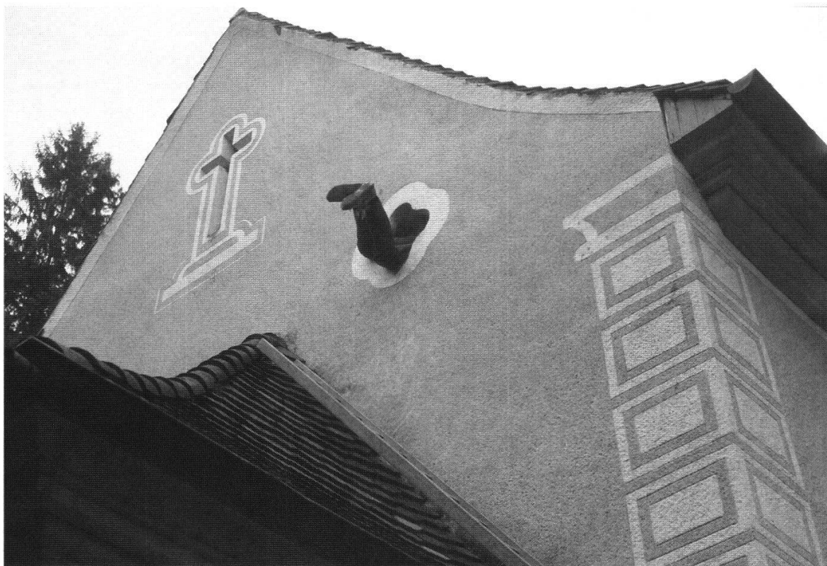
Abb. 2: Dachstockkontrolle unter erschwerten Umständen in Jonen.
