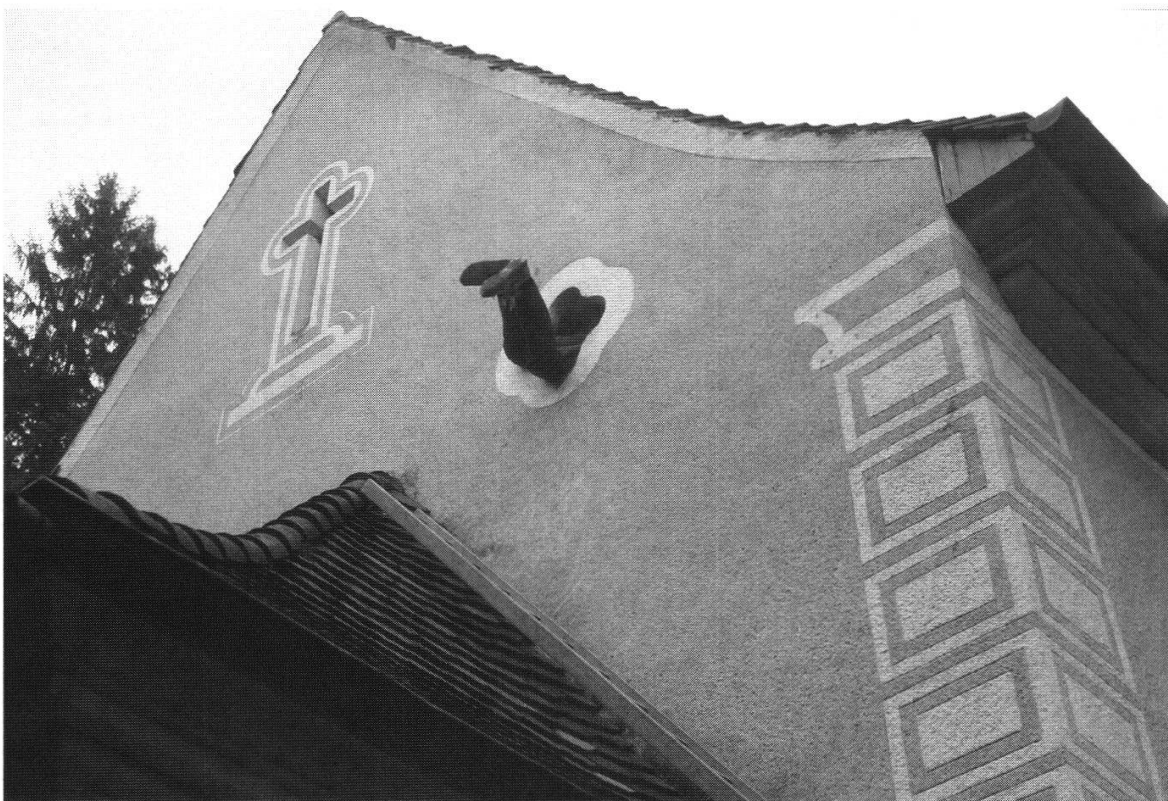
Abb. 2: Dachstockkontrolle unter erschwerten Umständen in Jonen.
