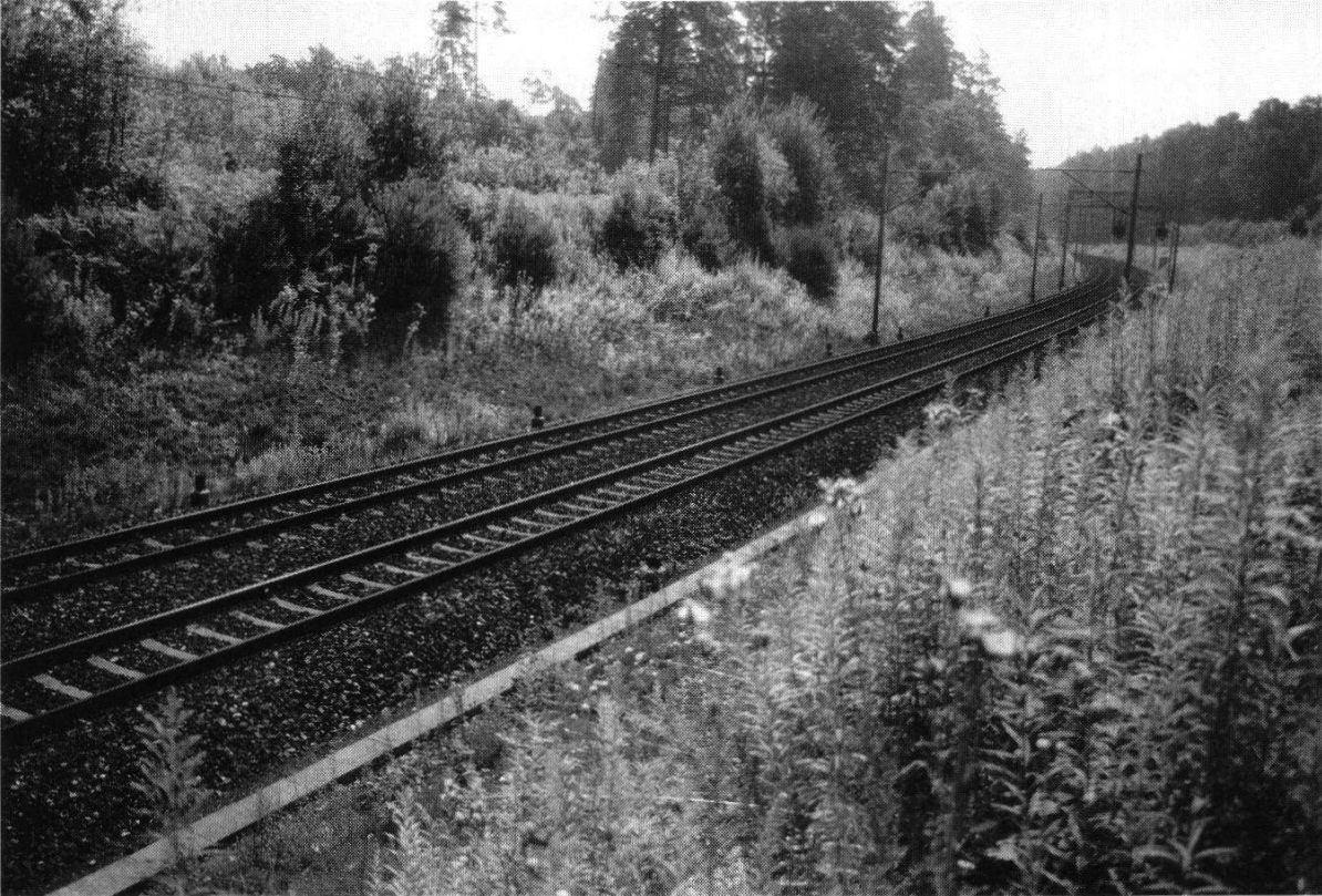
Abb.22: Eisenbahnböschung mit einer gut ausgeprägten Krautschicht und einer optimal gelegenen, breiten Buschhecke. Lebensraum der Zauneidechse ( L. agilis ) sowie der Blind- schleiche ( A. fragilis ).
