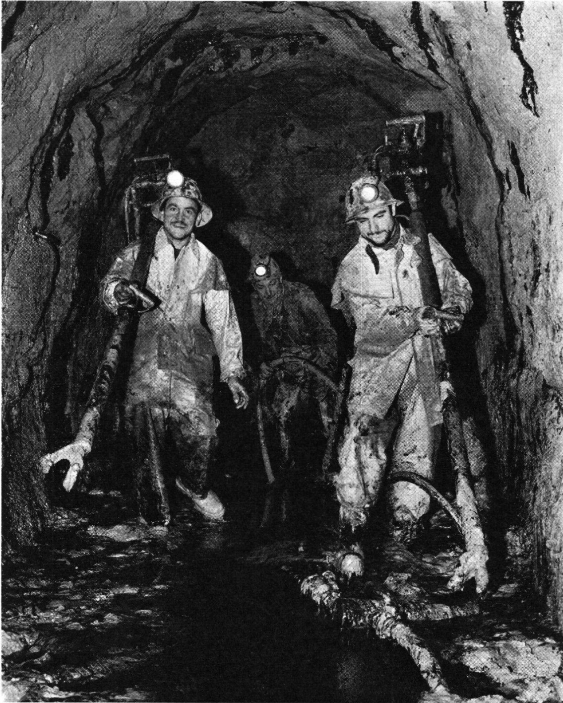
Abb. 11. Die Bohrmannschaft bei etwa 345 m vom nördlichen Stolleneingang. Von den Stollenwänden und der Decke fließt Öl und vermischt sich mit Wasser zu einem äußerst anhänglichen und über knöcheltiefen Schlamm (Photo FRÖHLICH)
