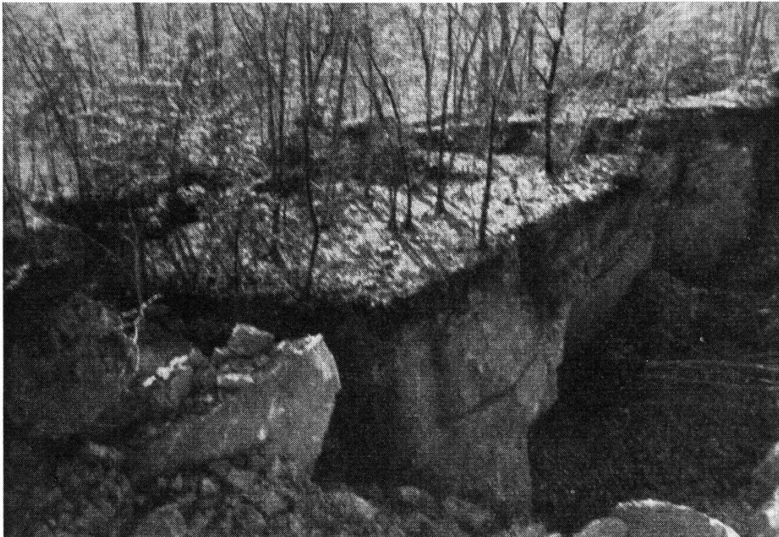
Abb. 2. Oberer Teil der verschobenen Scholle, zerrissen, etwa 12 bis 15 m tiefer als die obere Kante
