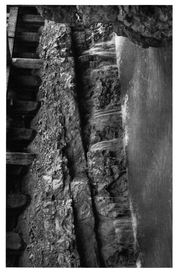
Abb. 3. Einbruch von großen Wassermengen in den Schichtfugen des Trigonodusdolomites in die geöffnete Baugrube des Kraftwerkes Klingnau
