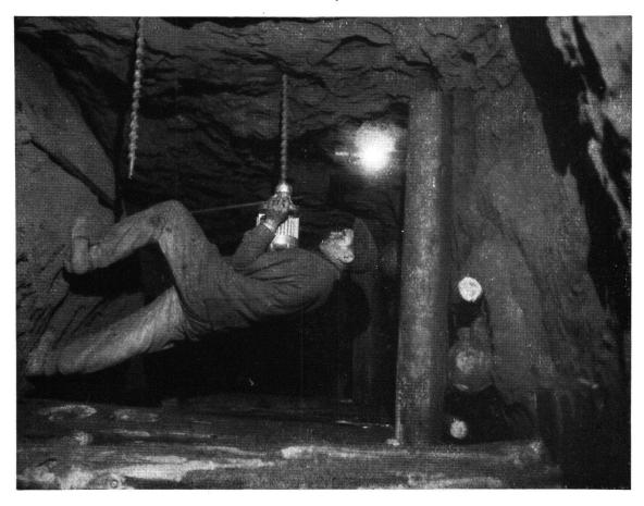
Fricktal: Elektrische Bohrmaschine im Abbau
