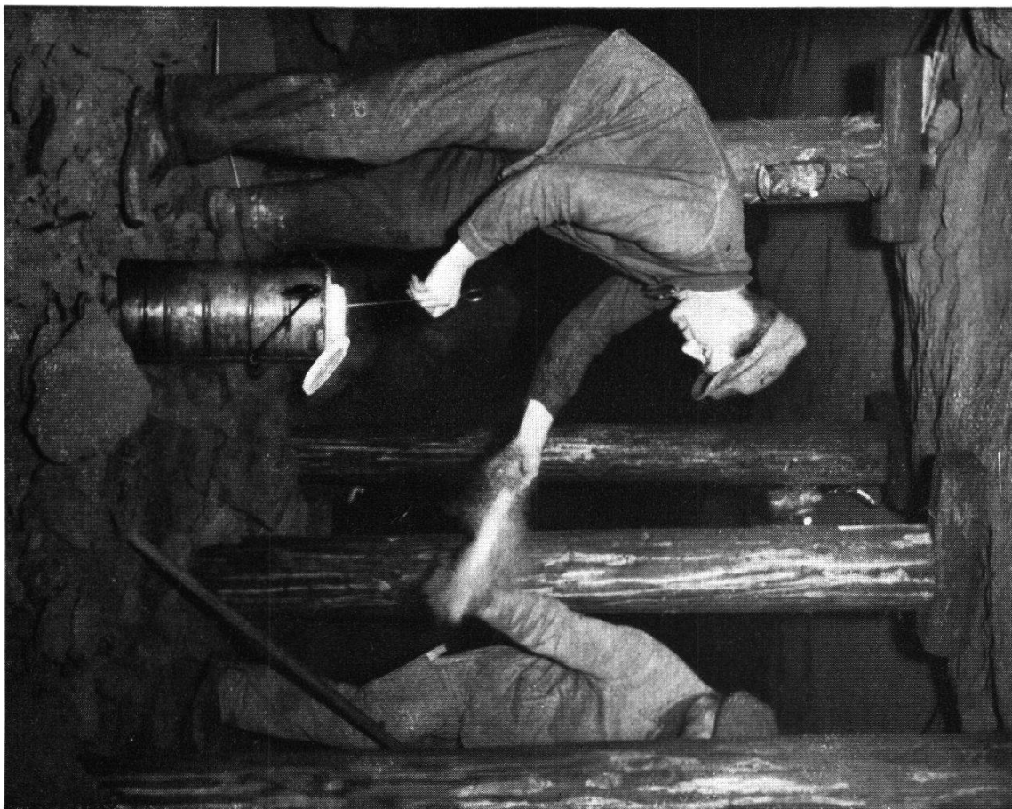
Fricktal: Schießen mit flüssigem Sauerstoff
