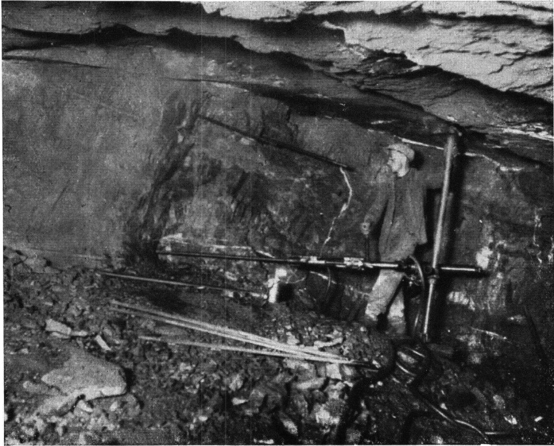
Gonzen: Bohrmaschine im Erzabbau
