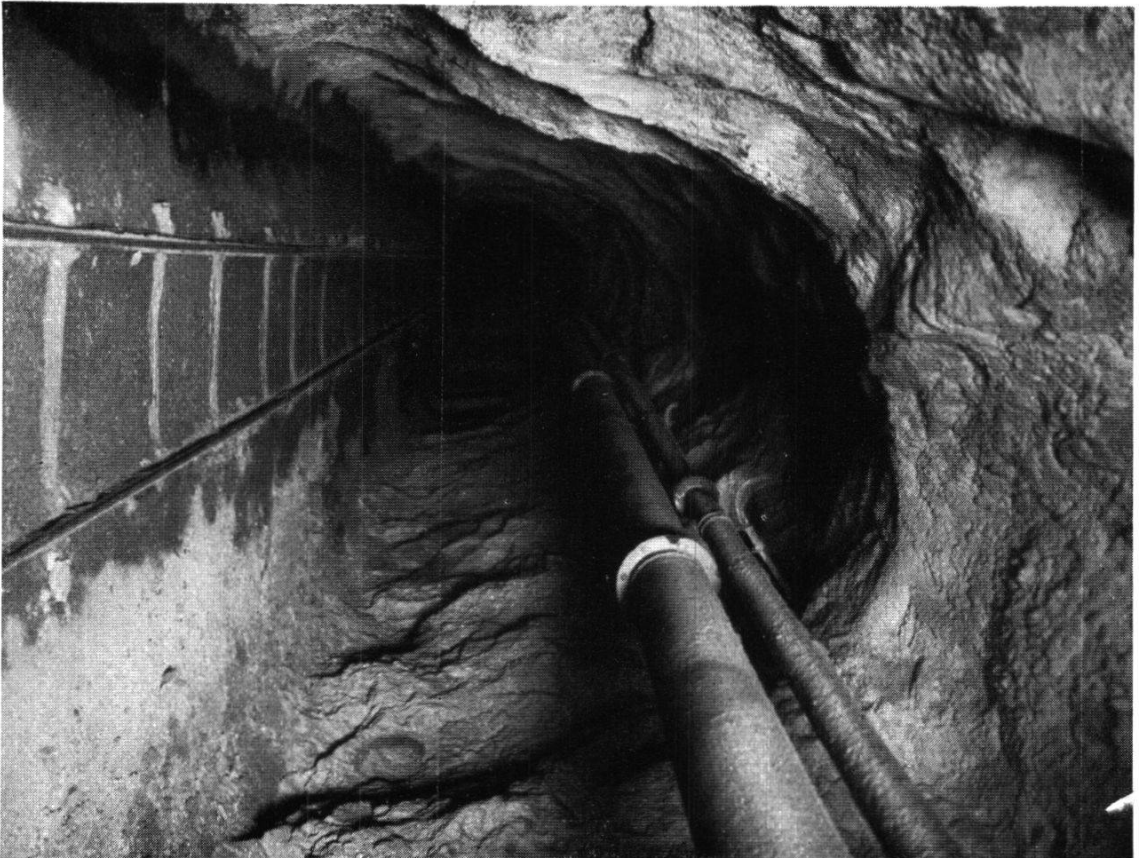
Fricktal: Versuchsstollen, gunitiert, mit Druckluft- und Ventilationsleitungen
