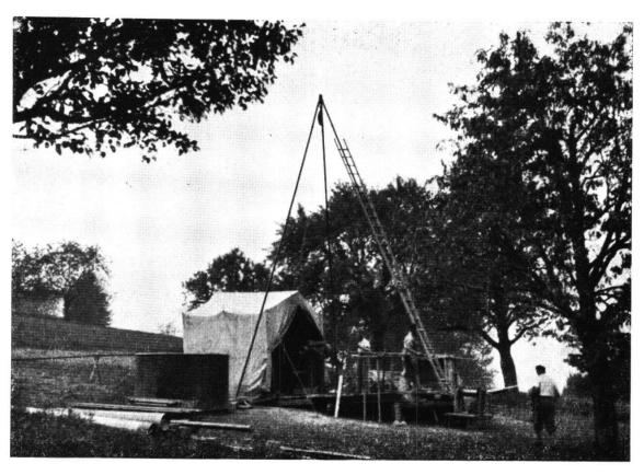
Fricktal: Kernbohrungen, ausgeführt von der A.-G. für Grundwasserbauten, Bern, Kern-Durchmesser 85 mm, Kerngewinnung im Erz über 90  $^{\rm o}/_{\rm o}$
