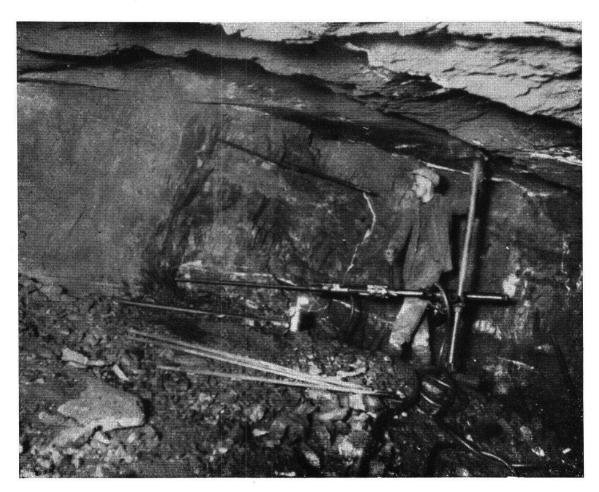
Gonzen: Bohrmaschine im Erzabbau
