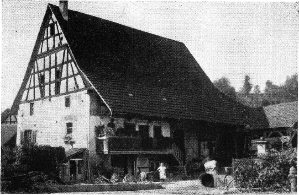
Bild 24. Elfingen. Riegelhaus. Eine Treppe führt zur Laube, welche die Verbindung der obern Räume herstellt. Zustand vor 1927, wo leider bei einer Renovation das Fachwerk übertüncht wurde.
