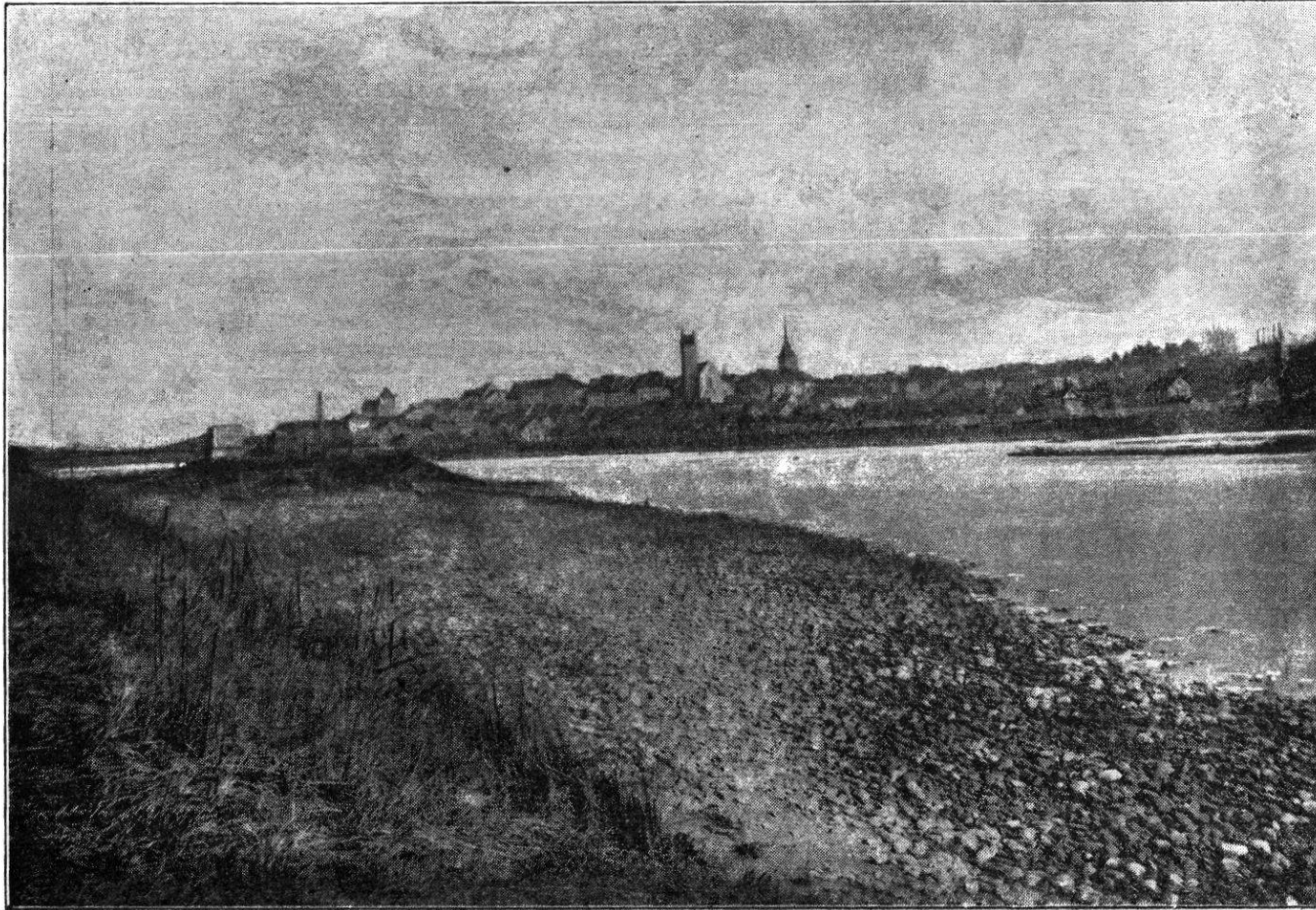
Verlandung des westlich von Aarau ausserhalb des jetzigen Elektrizitätskanals im Jahr 1854 erstellten Kanals durch von der Aare eingeschwemmtem Kies. (1886.) Seite 85.
