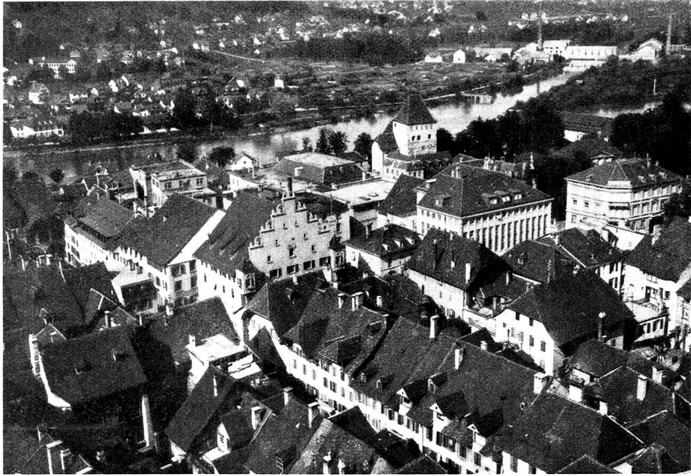
Photogr. Aufnahme durch Archit. G. Gysler-Frey von der Plattform des Turmgerüsts
