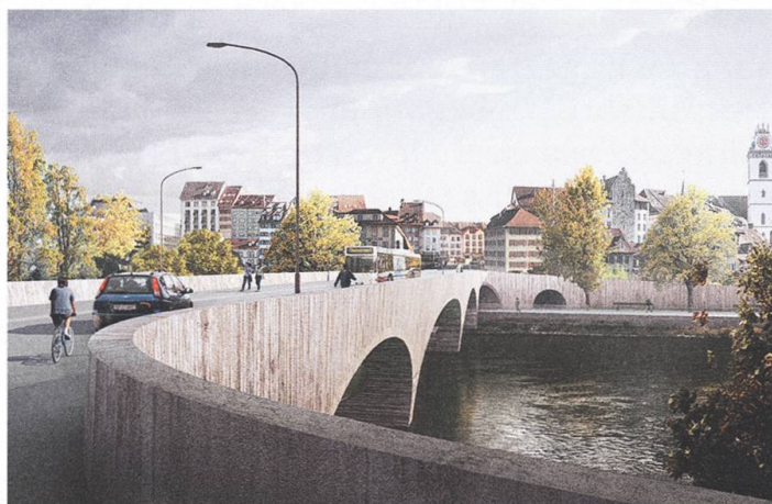
→ Blick von Norden Richtung Stadt Aarau auf die zukünftige Aarebrücke «Pont Neuf». (Foto: INGE Pont Neuf, Christ Gantenbein Architekten)
