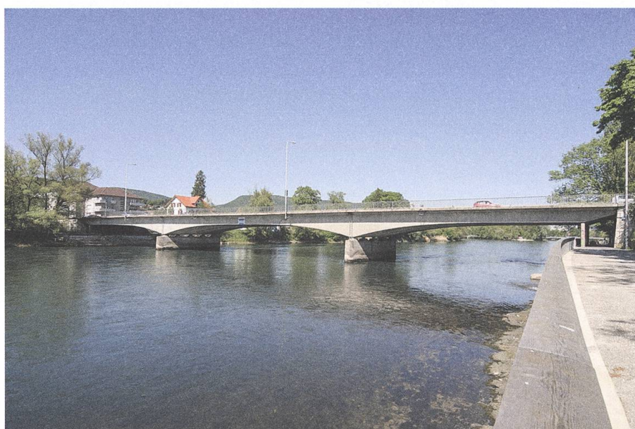
← Am 11. November 1949 war die neue Aarebrücke – weiterhin unter dem Namen «Kettenbrücke» bekannt – feierlich eröffnet worden. (Foto: Kanton Aargau)
