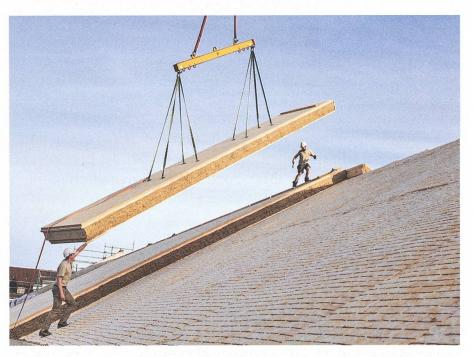
→ Montage der zwölf Meter langen Überdach-Elemente. (Foto: Luca Zanier Photography, Zürich)
