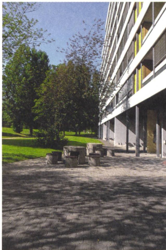
→ Verbindungsweg mit Sitzgelegenheit vor Hauseingang.
