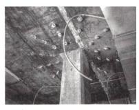
↑ Bei ungenügend ausgebildetem Stützenkopf können die Stützen die tragen und durchstanzen diese. Dieses Risiko erhöht sich im Brandfall. Mit sternförmig in die Decke gebohrten Ankern kann der Stützenkopf verstärkt werden.
