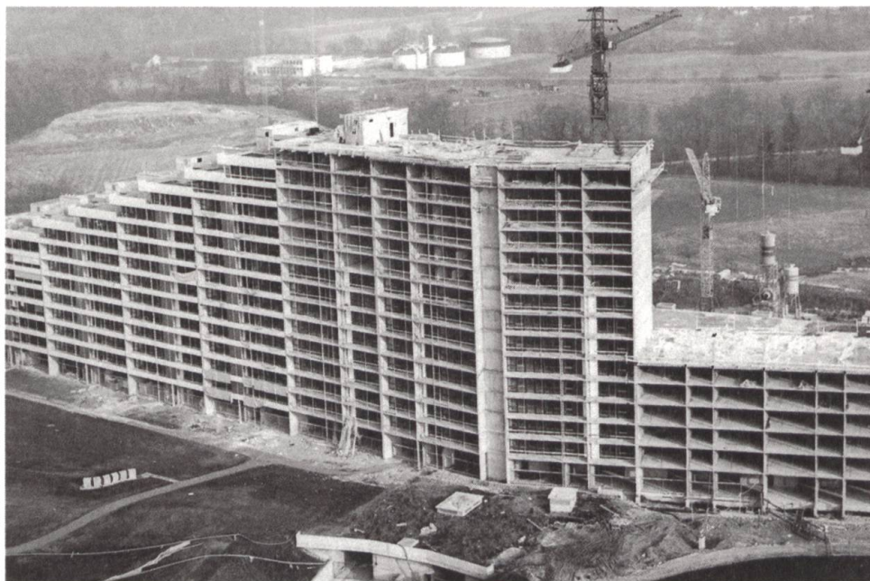
↑ Rohbau der im «Taktverfahren» erstellten Wohnzeile Rüt matt, um 1972. Ein Geschoss mit zwei Wohnungen wird innerhalb von 7,5 Arbeitstagen fertiggestellt. (Bild: Denkmalpflege)
