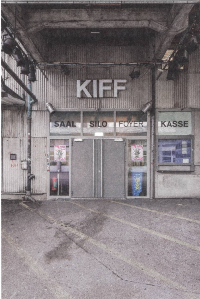
← Der Eingang des KIFF, wie er sich seit dem grossen Umbau 2000/01 präsentiert. (Fotografin: Sarah Keller)
