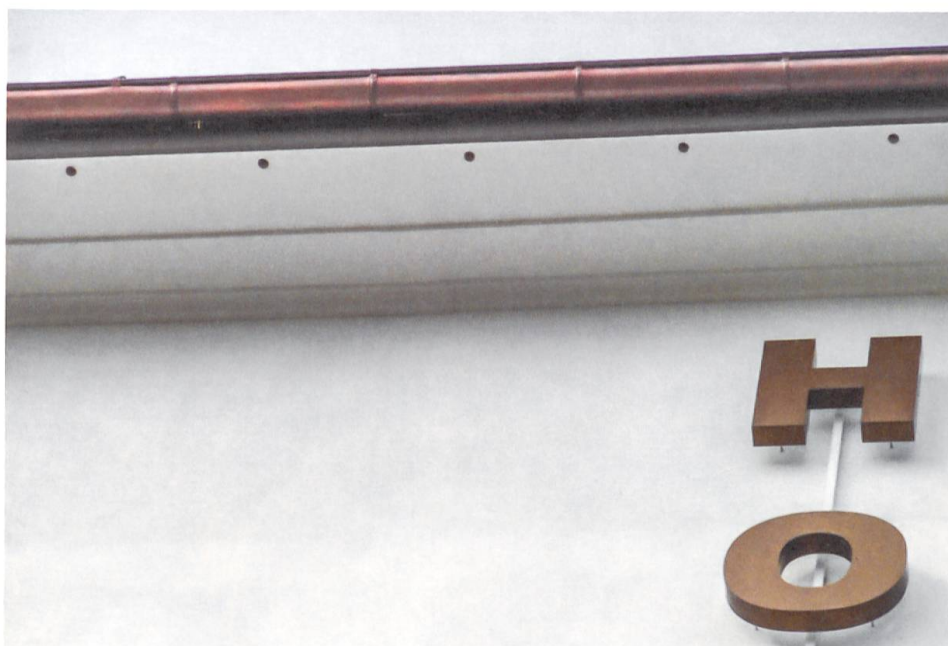
22 Hotel Kettenbrücke, Detail: Über jedem Anflugloch befindet sich ein Nistkasten für Mauersegler. (Foto: Bruno Zeller)
