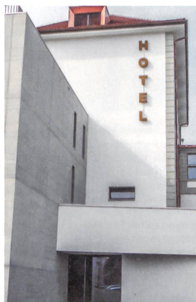
21 Hotel Kettenbrücke nach der Renovation, Ostseite. (Foto: Bruno Zeller)
