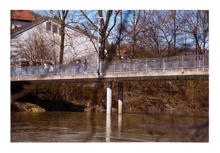
also keine Fugen und keine Lager auf den Flusspfeilern. Zudem hat sie eine geringe Konstruktionshöhe: die Brücke wirkt schlank. – Die statischen Berechnungen wurden mittels PC gemacht, die Pläne sowie die Materiallisten wurden noch von Hand gezeichnet.
