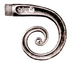
Als Handlauf diente ein 30 mm-Rohr. Das Traversenrohr mit 40 mm Durchmesser war später auch Hüllrohr für die Zuleitung der Elektroleitungen einer Strassenbeleuchtung. Die einzigen Schmuckelemente des Geländers waren die sogenannten «Schnörkel» am Ende der Geländerteile. Auch sie sind vorgefertigte Halbfabrikate.
