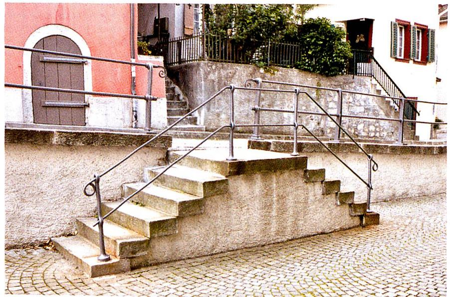
derhöhe von einem Meter mit dem alten Geländer erfüllt werden. Der Abstand des unteren Holms zum Boden ist mit der neuen, erhöhten Bordgestaltung ebenfalls normgerecht. Der Bordstein wird mit Gefälle gegen die Strasse und etwa 7 bis 10 cm auskragend über die Stützmauer hinaus versetzt, um diese gegen Witterungseinflüsse zu schützen.
