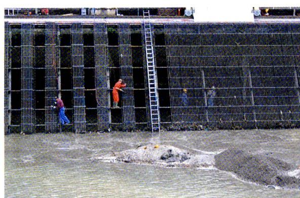
**25** Auf dem Grund des Kanals I wird Material umgelagert und der Boden neu modelliert oder planiert. Zum Teil wird auch Material weggebracht und in der Alten Aare deponiert. IBA.
