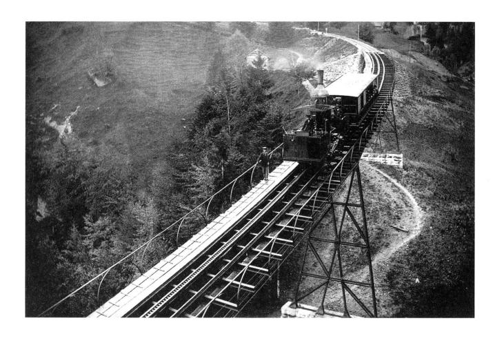
einer einfacheren Konstruktion der Zahnschiene zum erfolgreichen Konkurrenten von Niklaus Riggenbach werden sollte.<sup>8</sup> Unter den Bahnen, welche die Gesellschaft baute, befand sich auch die 1877 eröffnete «ficelle» Lausanne–Ouchy. Wie der Name der Bahn im Volksmund besagt, wurden die Wagen von einem Drahtseil gezogen. Später wurde die Bahn mit einer Abtschen Zahnschiene ausgestattet.
