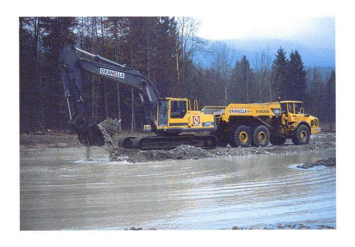
**7** Mit einem grossen 34-Tonnen-Bagger wurde das Material ausgehoben und mit einem 70-Tonnen-Dumper aufs Zwischendepot zum Abtropfen gebracht. abgetragen, und das ausgehobene Material wurde an zwei Stellen zu lokalen Steilufern aufgeschich-
