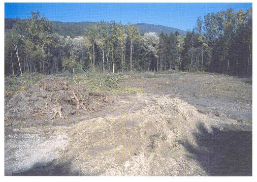
wurde gehäckselt. Danach wurden die Wurzelstöcke ausgegraben, auf Haufen geschichtet, mit einem leistungsstarken Grossmulcher zerkleinert und abtransportiert. Insgesamt wurden so fast 3000 Kubikmeter Material abgeführt.
