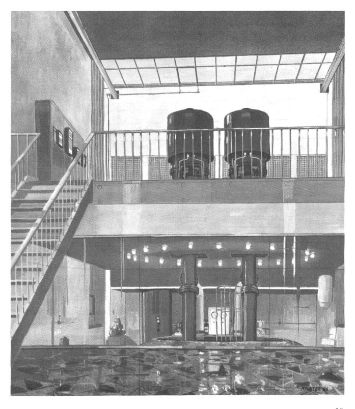
6 Ein Ausschnitt aus dem 1988 modernisierten Pumpwerk Brüelmatten. Zu sehen sind die Einrichtungen des Pumpwerkes (Leitungen, Armaturen und Klappensteuerung).
