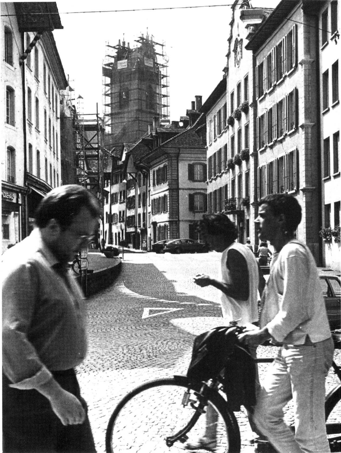
Mehr als die Hälfte 1981 eingerüstet: die Aarauer Stadtkirche in Renovation.
