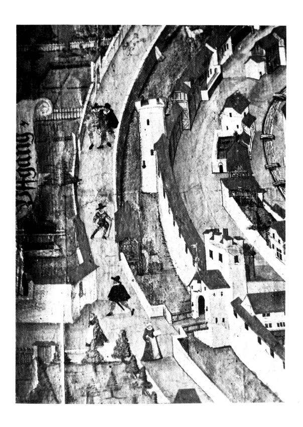
Abb. 17 Aarau von Norden, Ölbild von Hans Ulrich I Fisch, 1612. Ausschnitt der Laurenzentoranlage. Die durch den Bau des zweiten Tors entstandene Doppeltoranlage unterstreicht mit zwei Türmen die Bedeutung dieses Stadteingangs. Das äussere Tor ist durch das wohl erst um 1480 angebaute Vorwerk in den Graben hinaus erweitert. Aarau, Rathaus.
