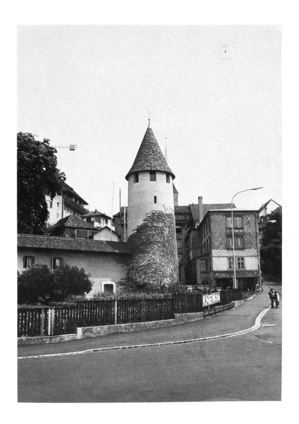
Abb. 37 Vollständig erhaltener Abschnitt der Klosterummauerung beim Ansatz an die habsburgische Mauer. Schlüssel- und Segmentbogenscharten.
