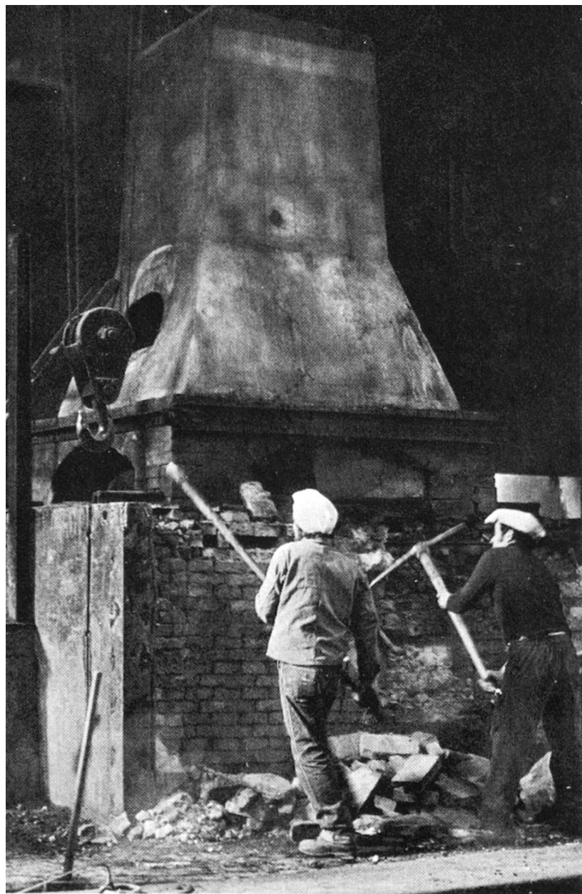
In der Glockengiesserei wird der letzte holzgeheizte Giessofen abgebrochen.
