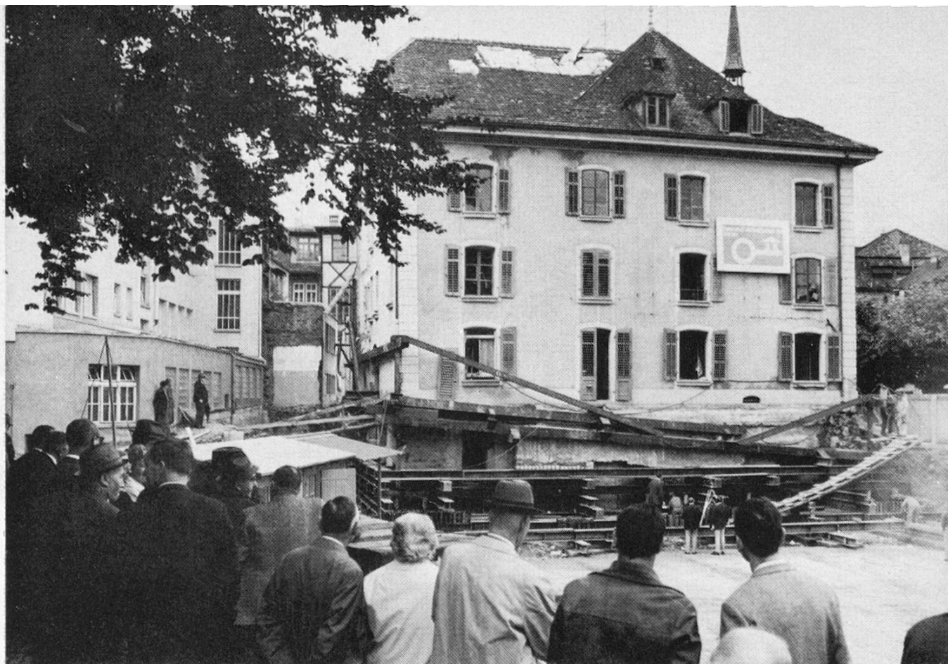
Eine technische Glanzleistung war die Verschiebung des rund 2750 Tonnen schweren, etwa 180jährigen Hubscherhauses am Graben, welches in rund vierzig Tagen 54 Meter weit verschoben und dabei abgedreht wurde. 950000 Franken kostete diese «Hausreise» alles in allem.
