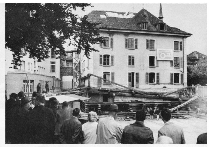
Eine technische Glanzleistung war die Verschiebung des rund 2750 Tonnen schweren, etwa 180jährigen Hübscherhauses am Graben, welches in rund vierzig Tagen 54 Meter weit verschoben und dabei abgedreht wurde. 950 000 Franken kostete diese «Hausreise» alles in allem.
