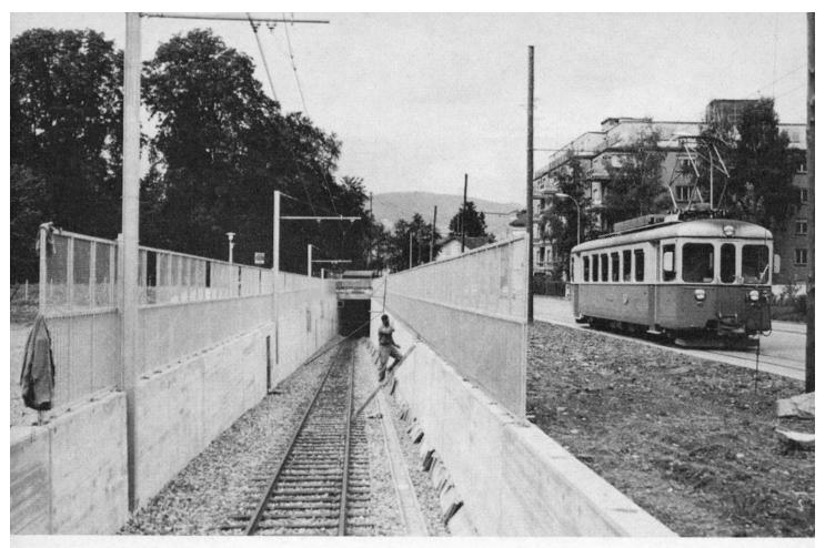
Eine Teillösung der Verkehrsprobleme brachte der Zusammenschluss der WSB. Zu diesem Zwecke wurde eine Tunnelröhre (260 m) erstellt; die Linie auf der Bahnhofstrasse konnte stillgelegt werden. Der WSB-Bahnhof wurde erweitert. Und während dieser Zeit erhielt Aarau auf der Hinteren Bahnhofstrasse ein «Hochbähnchen».
