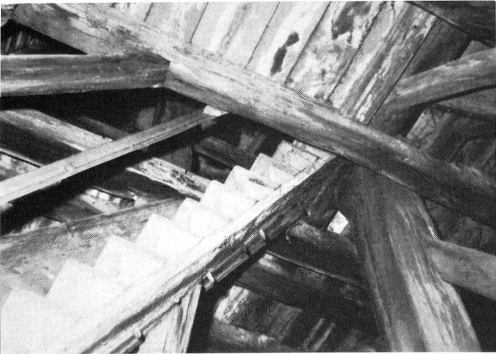
Aus mächtigen Balken besteht der Dachstuhl!
