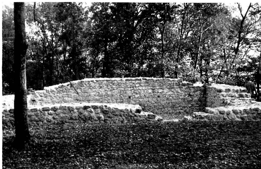
Die Burghaldenkuppe mit dem konservierten Mauerwerk am Ein- weihungstag, 28. September 1957
