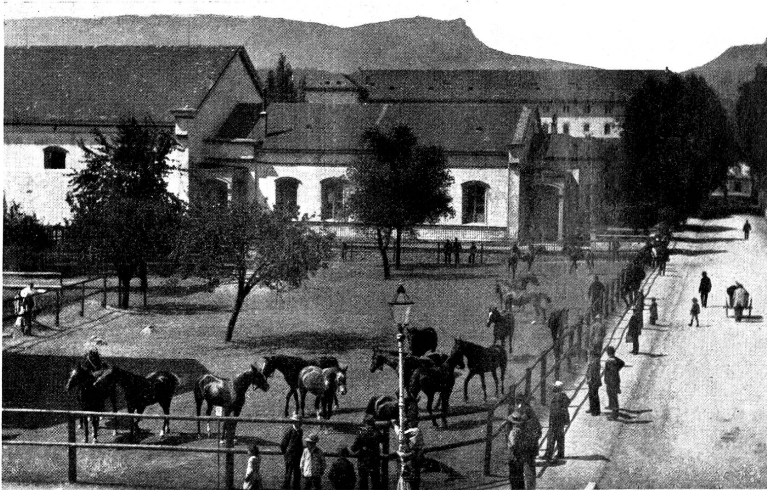
Zeughausstraße mit Turnhalle um 1870
