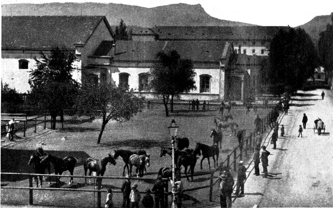
Zeughausstraße mit Turnhalle um 1870
