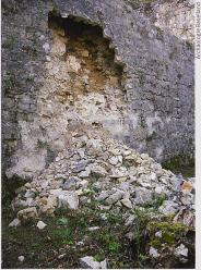
▲ Auswaschungen und damit verbundene Frostschäden haben zum Mauerausbruch in der Unterburg der Farnsburg geführt.
