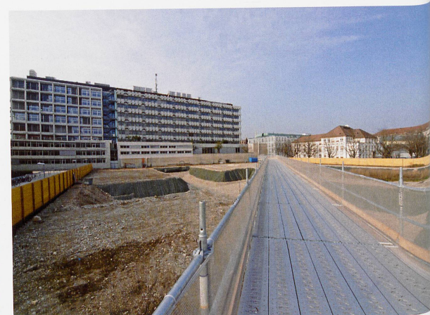
Schällemätteli damals (oben) und Baugrube heute.
