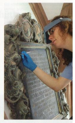
Konservierungsmethoden angewendet «Der ganze Restaurierungsprozess führt von der Anwendung schonender Reinigungstechniken über die Festigung der Oberflächen des Sandsteins, das Injizieren von Hohlräumen bis zum Aufmodellieren mit mineralischem Mörtel».
