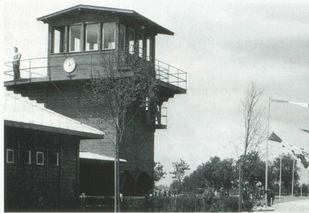
Bildlegende Kontrollturm in Basel-Mulhouse kurz vor der Eröffnung
