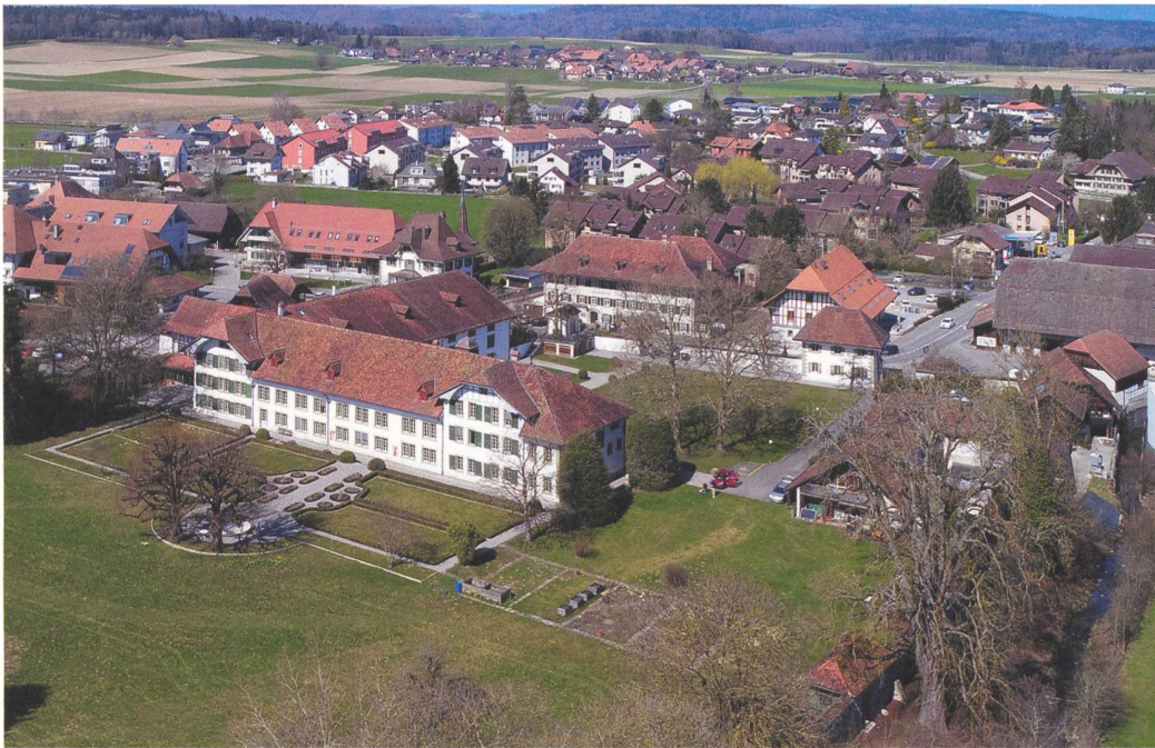
1 Fraubrunnen, Kloster. Gesamtansicht von Südosten mit der vom alten Klostergeviert übrig gebliebenen, L-förmigen Anlage: im Vordergrund der Südflügel mit seinen beiden Quergiebeln und Ründidächern, dahinter der quer dazu liegende Westflügel. Rechts im Bild ein kanalisierter Lauf der Urtenen.
