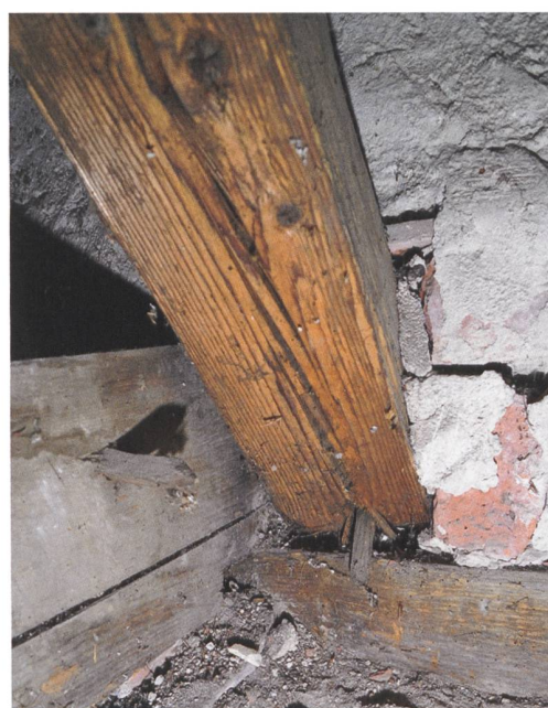
24 Fraubrunnen, Kloster. Dachwerk des Südflügels. 1. Querbundachse von Westen, südlicher Dachfusspunkt. Der einzige am Fusspunkt noch vollständig sichtbar erhaltene Rafen ist durch einen Holznagel gegen Abrutschen von der Schwelle gesichert.
