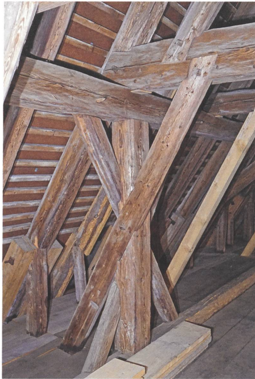
9 Olsberg AG, Kloster. Dachwerk der Kirche, 1427/28d. In der unteren Ebene sind die wenigen stehenden Stuhlsäulen mittels überkreuzter Streben mit der zusätzlichen Schwelle und dem Rähm verklammert.
