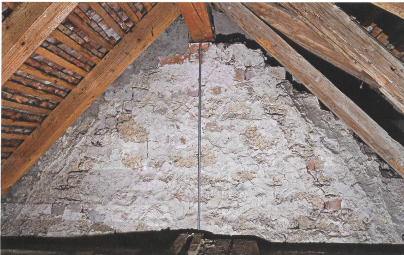
10 Fraubrunnen, Kloster. Dachraum über dem mittleren Teil des Westflügels. Giebel der Brandmauer mit Spuren des älteren Sparrendachs mit Kreuzstreben.
