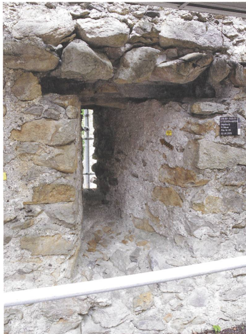
12 Stocken-Höfen, Burg-ruine «ze Stoke». Licht-schlitz Pos. 26, der östliche von zwei Öffnungen in der Nordwand.
