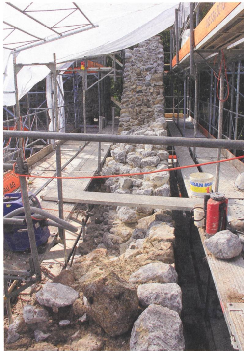
21 Stocken-Höfen, Burg-ruine «ze Stoke». Die neu aufgemauerte Verschleisschicht auf der Mauerkrone der Nordmauer. Aufnahme der ersten Sanierungsetappe im Jahr 2020.
