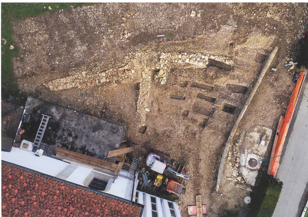
6 Tramelan, Grand Rue 146. Vue polaire (drone) des sections de murs de l'ancien cimetière et de quelques tombes vidangées. À droite, la citerne de 1877 coiffée d'une dalle calcaire fermée par un couvercle de fonte (flèche).
