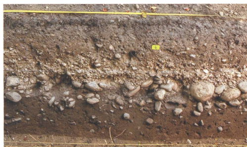
30 Bern, Römerstrasse Forst 2023. Rund 2 m breiter Ausschnitt des Ostprofils von Sondierung 2. Der mehrteilige Aufbau der kaiserzeitlichen Strasse ist gut erkennbar. Blick nach Osten.
