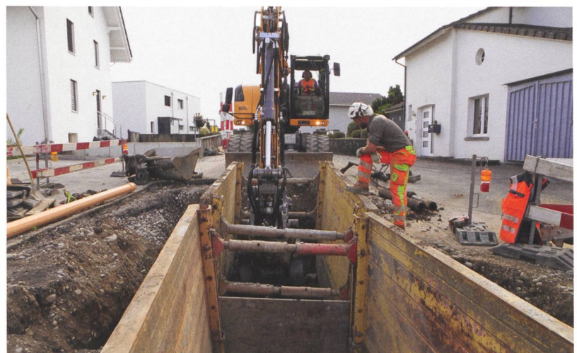
3 Roggwil, Werkleitungsbegleitung 2023/24. Baggeraushub innerhalb der Grabenspriessung im Bereich des spätlatènezeitlichen Befestigungsgrabens (bei Profil 11). Hinten links die Liegenschaft Kilchweg 7, wo 2019 der nördliche Grabenrand dokumentiert wurde. Blick nach Südosten.
