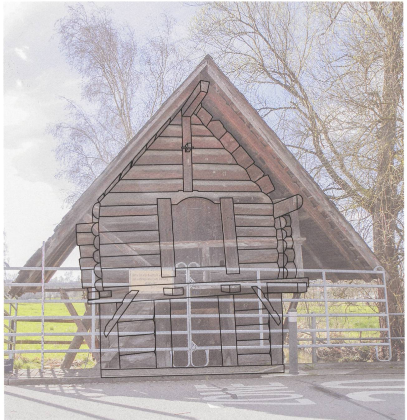
4 (oben) Niederönz, Mühlestrasse 37. Der Speicher wurde teilweise über der Önz errichtet. Die drei im Wasser stehenden Punktfundamente sind aus Zementbacksteinen gemauert. Blick nach Nordosten.
