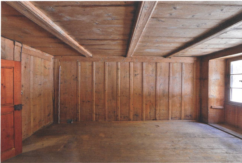
8 Meiringen, Unterbach Unterheid 247. Die Wandtäfer, Unterzüge und Deckenbretter stammen noch aus der Schulhauszeit. Die Fenster wie auch der Boden wurden nachträglich erneuert. Blick nach Osten.
