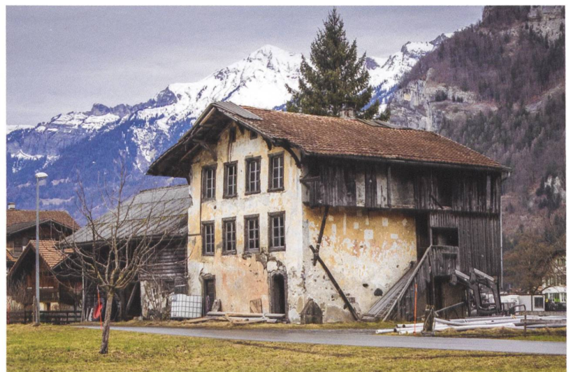
7 Meiringen, Unterbach Unterheid 247. Das Schulhaus mit Treppe zum Eingang im ersten Obergeschoss und den Lauben auf der Ostseite des Gebäudes. Blick nach Nordwesten.
