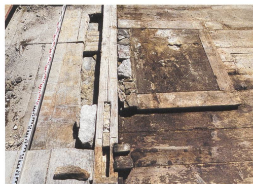
12 Meiringen, Unterbach Unterheid 247. Nach 1876 wurde die Schulstube unterteilt und mit einem ersten Sitzofen eine Stube im Südosten geschaffen. Der Ofensockel lag auf dem geflickten und stark abgenutzten Schulstubenboden. Blick nach Osten.
