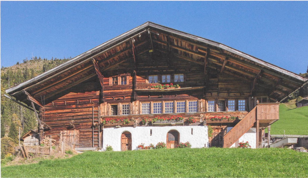
2 Diemtigen, Kileystrasse 17. Westfassade des Hauses.
