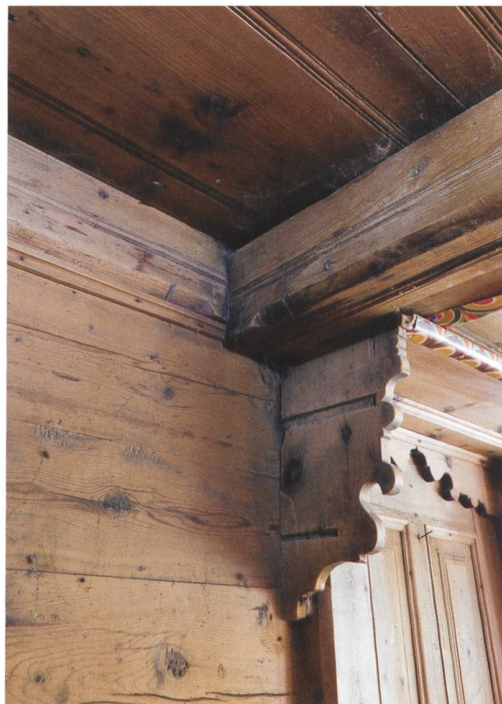
5 Diemtigen, Kileystrasse 17. Erstes Wohngeschoss, nördliche Kammer. Profilierungen der Rähme, des Unterzugs und der Deckenbohlen.
