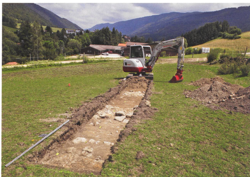
5 Court, Mévilier. Le sondage 1 a confirmé le faible enfouissement des murs de l'église, ici au niveau des deux chœurs successifs.
