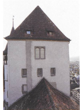
23 Burgdorf, Schloss, Nordwehrmauer
