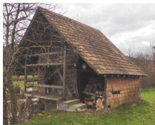
76 Seeberg, Grasswil, Feldstrasse 3a
