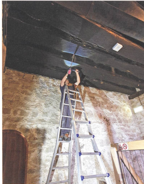
14 Die Deckenbalken des Bergfriedes von Schloss Trachselwald konnten dendrochronologisch in die Jahre 1248–1254 datiert werden.
