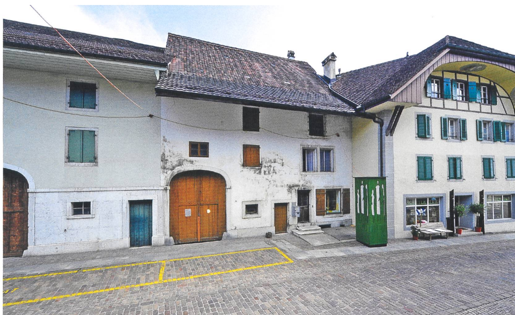
6 Wiedlisbach, Städtli 29. Ansicht der Nordfassade. Blick nach Südwesten. Aufnahme von 2017.
