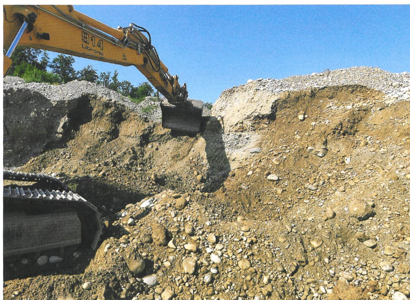
1 Wynau, Ägerte Kieswerk. Kiesabbau am Fundort 2023.
