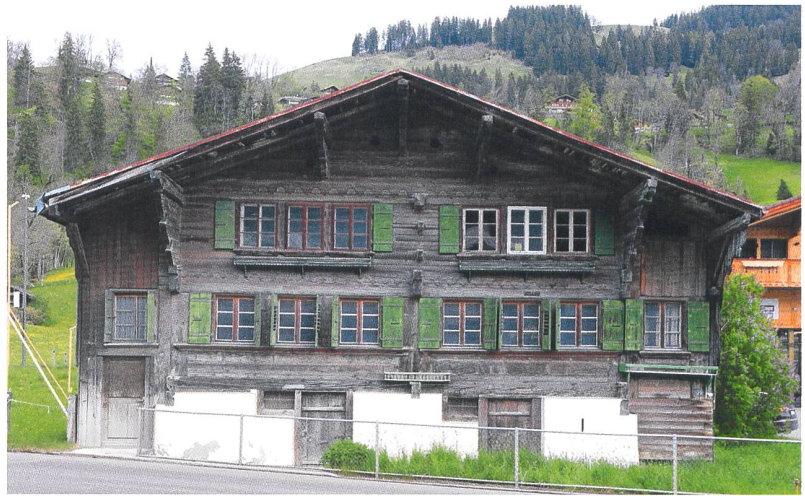
4 Saanen, Dorfstrasse 120. Südfassade. Blick nach Norden. Zustand Mai 2022.
