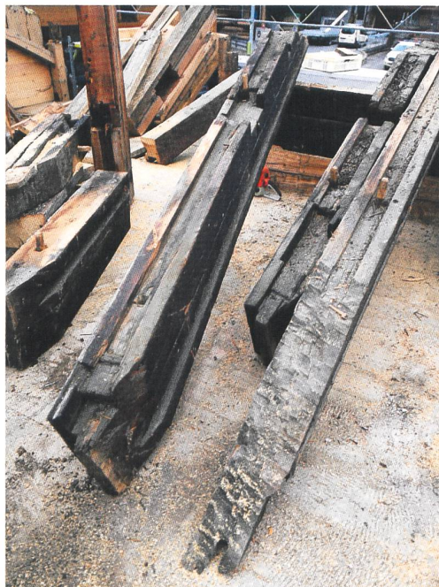
5 Saanen, Dorfstrasse 120. Balken eines Bohlen-Ständer-Baus mit zwei Längsnuten, zu einem unbestimmten Zeitpunkt vor 1672 gefällt, 1672 verkürzt und sekundär umgearbeitet zu einem Kantholz der Nordwand im zweiten Wohngeschoss. Aufnahme während des Abbruchs im Jahr 2022. Blick nach Nordosten.
