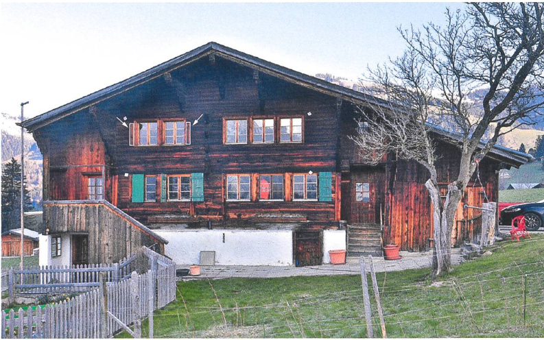
2 Saanen, Tüllerliweg 3. Südfassade. Rot: Links und rechts der linken Fensterreihe im zweiten Wohngeschoss sind die bauzeitlichen Fensterpfosten der Kammern zu erkennen. Blick nach Norden. Zustand April 2023.
