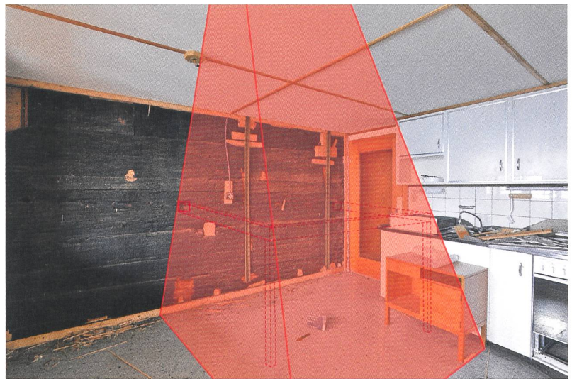
6 Oberried, Am Quai 43. Luftraum der Rauchküche in der Südwestecke des Hauses auf der Höhe des zweiten Wohngeschosses. Rot: Die zwei quadratischen Ausnehmungen in der oberflächlich stark verrussten Ostwand und die darin steckenden Balkenstummel stammen vom Traggerüst des Rauchfangs; rot transparent: Rekonstruktion des Rauchfangs.
